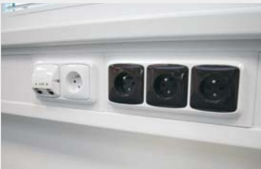
Пример монтажа паряпетного кабель-канала PK 140X70 D с приборной коробкой КР РК и приборной рамкой 8440-...
